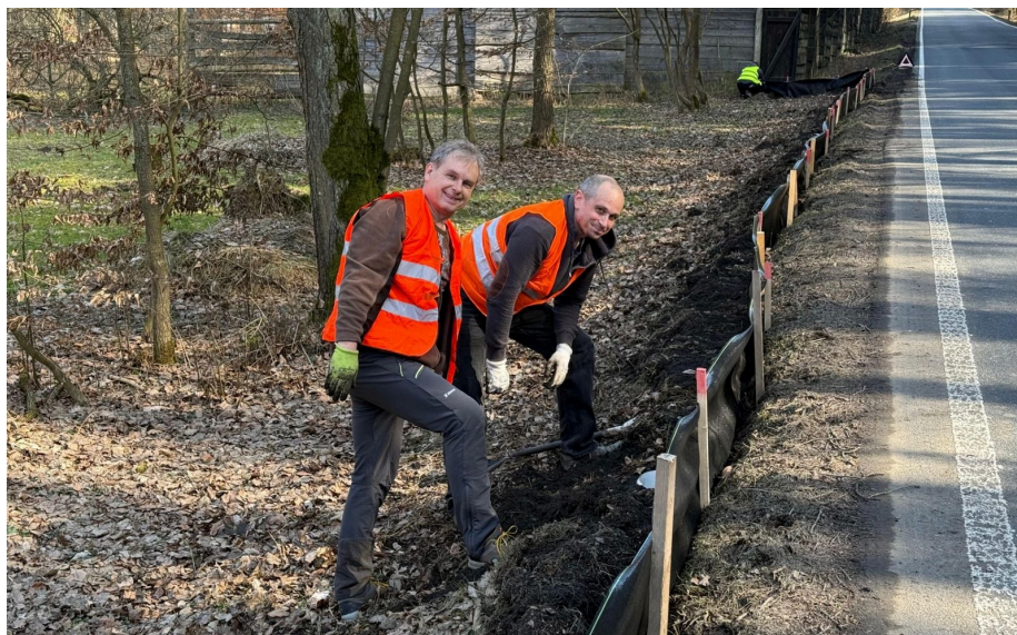
Budování zábran pro obojživelníky
