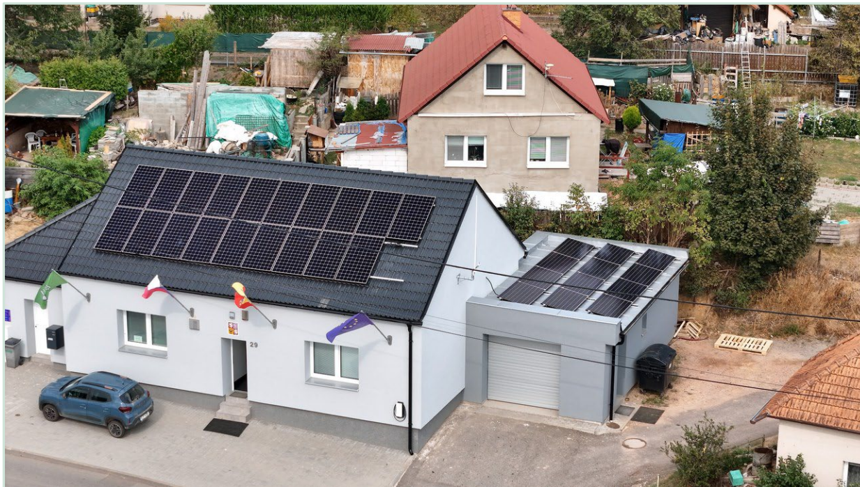
Letecký pohled na obecní úřad (č. p. 29) s fotovoltaikou na střeše a garáži.
