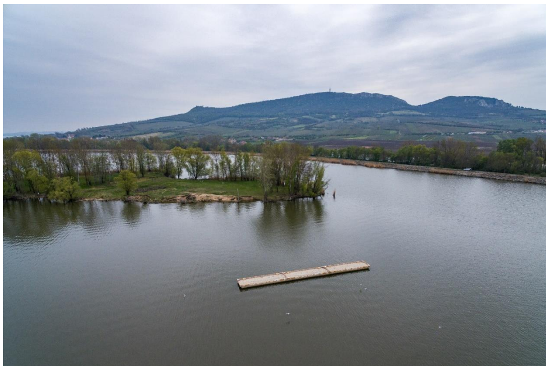
Obr. 24: Další z kompenzačních opatření na střední nádrží VD Nové Mlýny pro obnovení původního zásobního prostoru – Instalace vlnolamů ke Kostelnímu ostrovu a k souostroví Písky.
