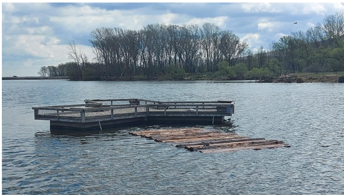
Obr. 22: Jedno z kompenzačních opatření na střední nádrži VD Nové Mlýny pro obnovení původního zásobního prostoru – instalace plovoucích plošin k hnízdním ostrovům rybáka obecného.
