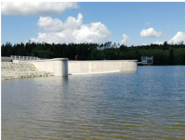
Obr. 28: VN Boskovice prošla v nedávné době úpravami a modernizací a je připravena obnovit svoji vodárenskou funkci
