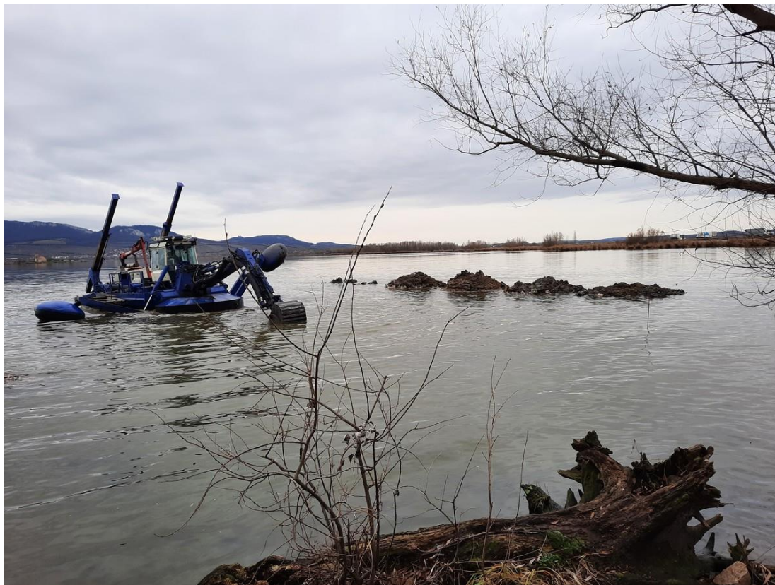
Obr. 23: Další z kompenzačních opatření na střední nádrží VD Nové Mlýny pro obnovení původního zásobního prostoru – překopání zaplavené lvaňské cesty.
