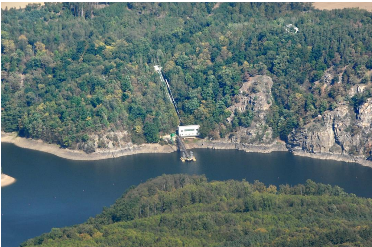
Obr. 27: Stávající odběrný objekt na VN Vranov. Do budoucna by měla plovoucí ponton nahradit pevná odběrná věž.
