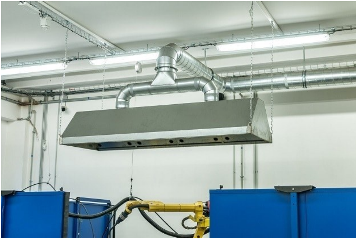
Obr. 3, příklad odsávání stacionárního zdroje, manipulace s uhlím
