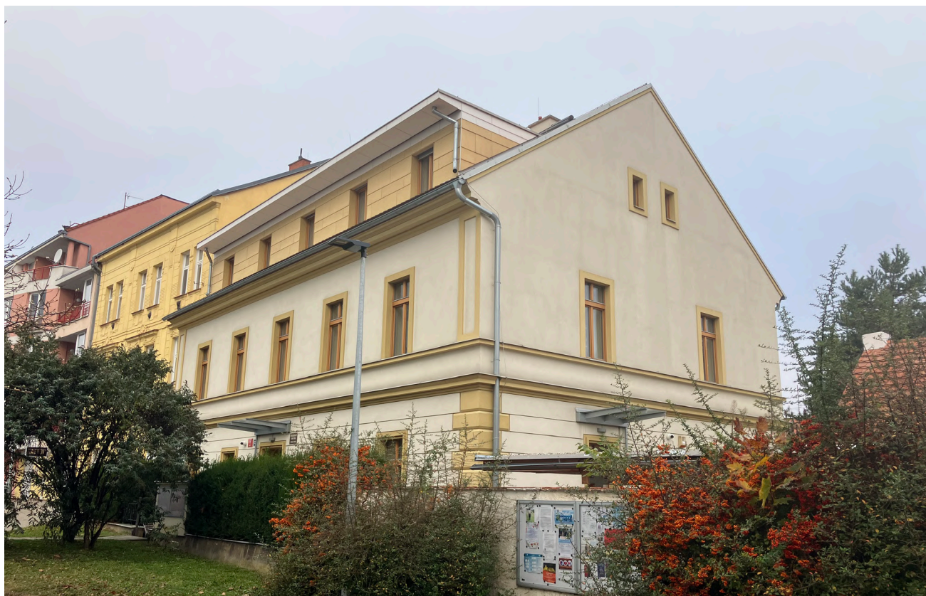
Obrázek 54: Uliční zdobná fasáda fary s reprofilací původních zdobných prvků a říms pomocí tvarovaného polystyrenu; foto: Michal Čejka, Centrum pasivního domu z.s.
