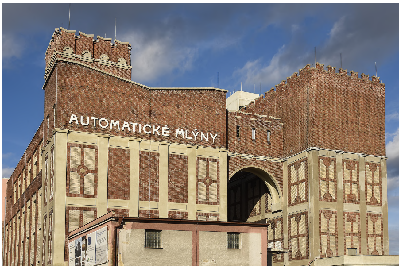
Obrázek 62: Štítová stěna po obnově; foto: Fotoarchiv Metrostav a.s.
