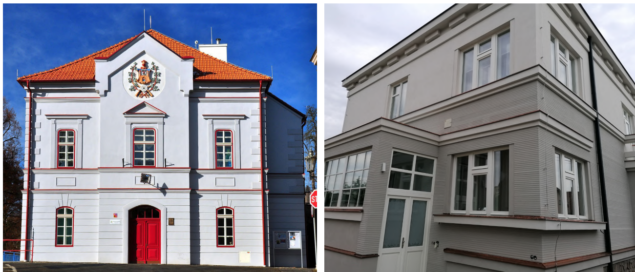
Obrázek 11: Vnější zateplovací systém s reprofilací pomocí izolantu; foto: archiv projekty Sedláková +Baumit
