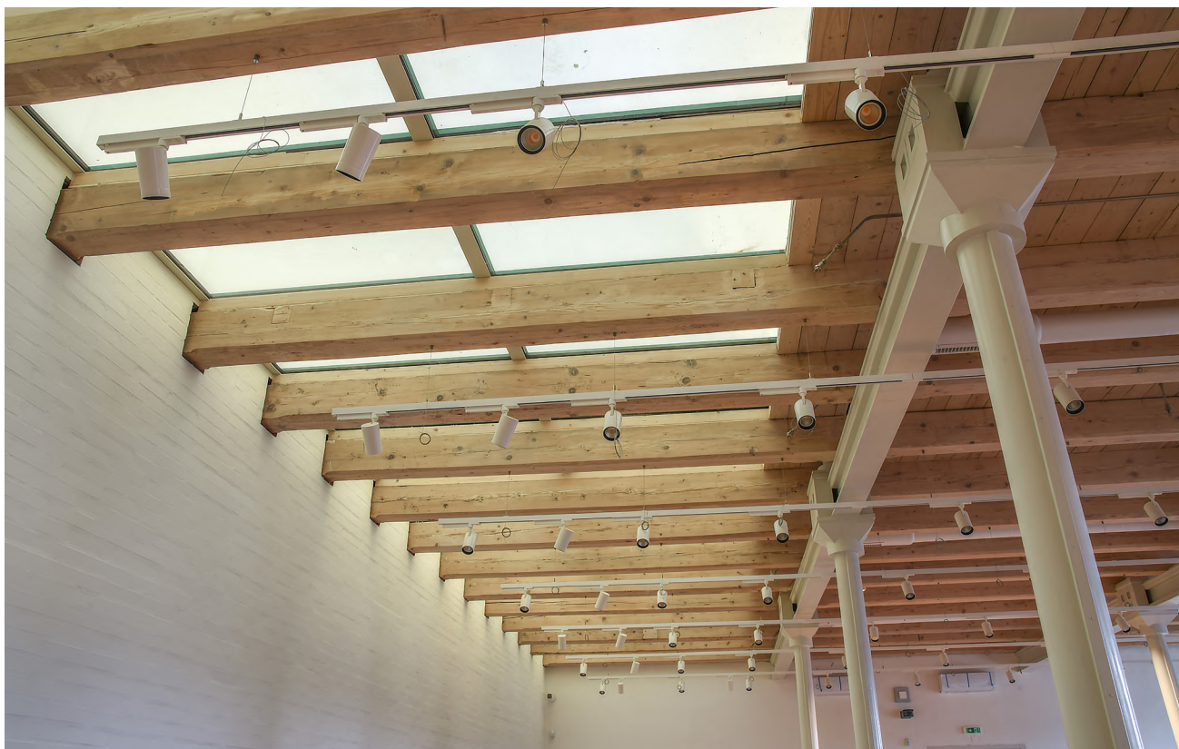
Obrázek 14: Vnitřní zateplení budovy s trémovými stropy kapilárně aktivním izolantem; foto: Jan Klečka
