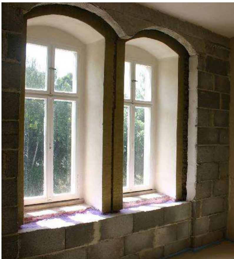
Obrázek 17: Zateplení historické budovy formou vestavby nové konstrukce a izolováním vzniklého meziprostoru strouhaným extrudovaným polystyrenem; foto: Michal Čejka, Centrum pasivního domu
