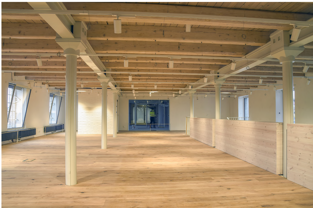
Obrázek 64: Expoziční prostory – zachování původních trámů, sklopné vnitřní výplně; foto: Fotoarchiv Metrostav a.s.
