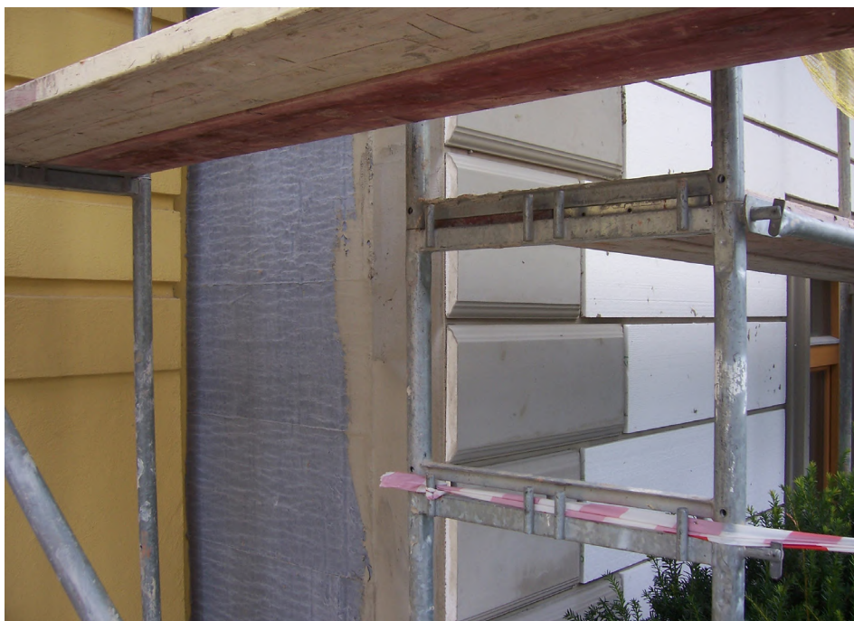
Obrázek 20: Realizace aerogelu z vnější strany budovy v místě s omezenou možností realizace dostatečné tloušťky tepelného izolantu; foto: Propasiv s.r.o.
