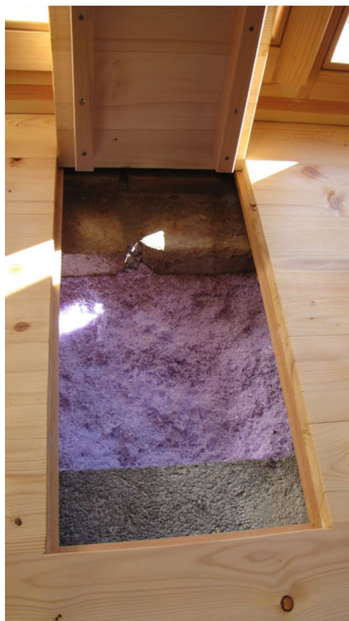
Obrázek 17: Zateplení historické budovy formou vestavby nové konstrukce a izolováním vzniklého meziprostoru strouhaným extrudovaným polystyrenem; foto: Michal Čejka, Centrum pasivního domu
