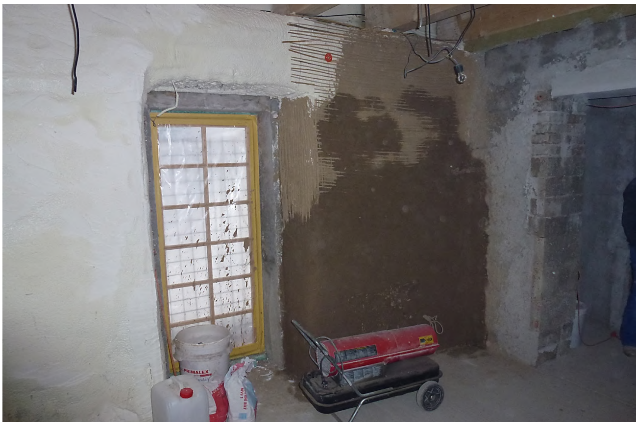
Obrázek 60: Vnitřní nástřik z PUR pěny v tl. 80 mm s hliněnou omítkou do rákosové rohože; foto: Josef Smola, Centrum pasivního domu z.s.
