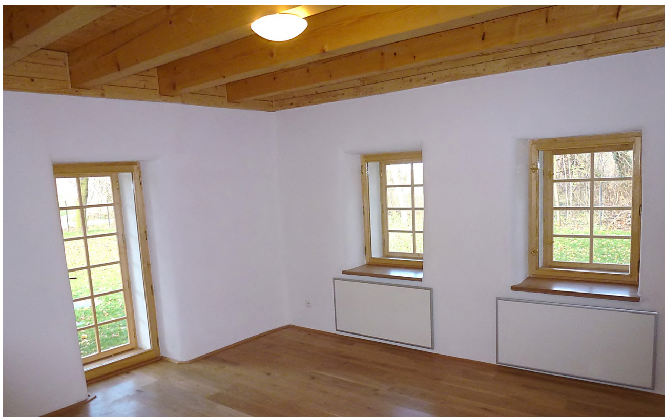
Obrázek 61: Finální vnitřní úprava – špaletová okna s vnitřním trojsklem a vnější replikou, hliněné omítky, elektrické přímotopy; foto: Josef Smola, Centrum pasivního domu z.s.
