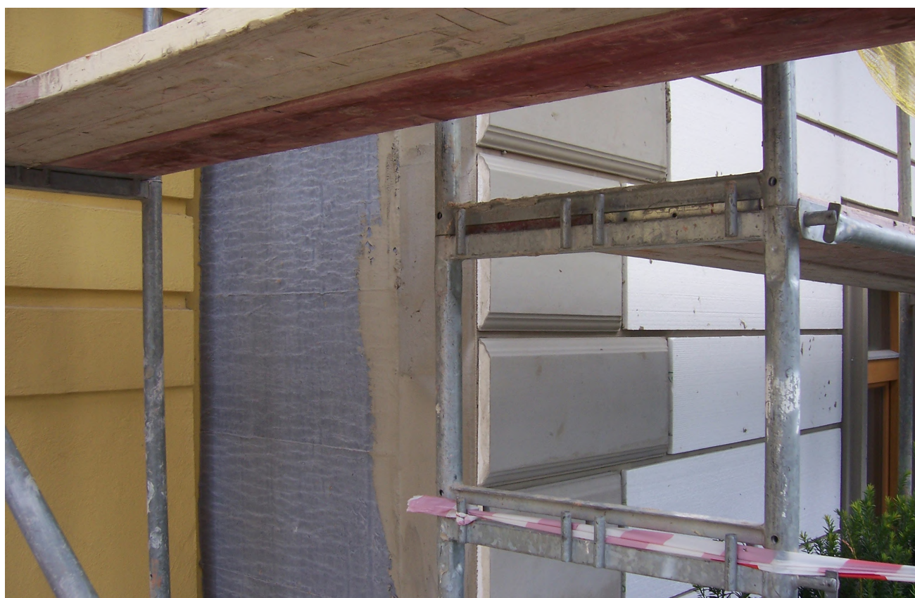
Obrázek 53: Reprofilace zdobných prvků a aerogel na štítové stěně před finální povrchovou úpravou; foto: Propasiv s.r.o.
