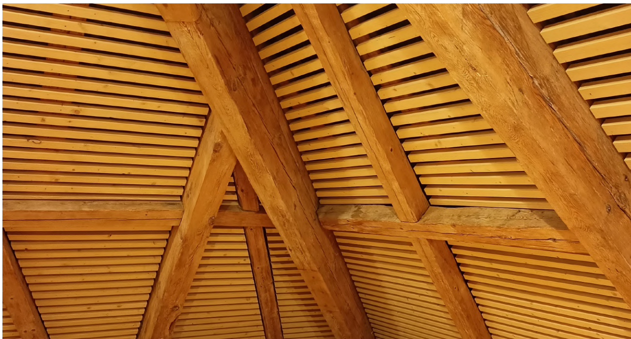
Obrázek 21: Renovace střešního pláště s nadkrokevní tepelnou izolací s vnitřní pohledovou úpravou; foto: Jiří Vácha, Biskupství českobudějovické
