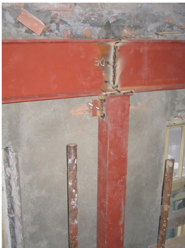
Obrázek 15: Zateplení historicky cenné fasády z vnitřní strany pomocí nanovláknité izolace aerogel - nevyhovující stropní konstrukce je nahrazena novou (ocelové nosníky), oddělenou od fasády tak, aby bylo možné tepelný izolant vést bez přerušení v celé ploše stěny; foto: Tomáš Vanický
