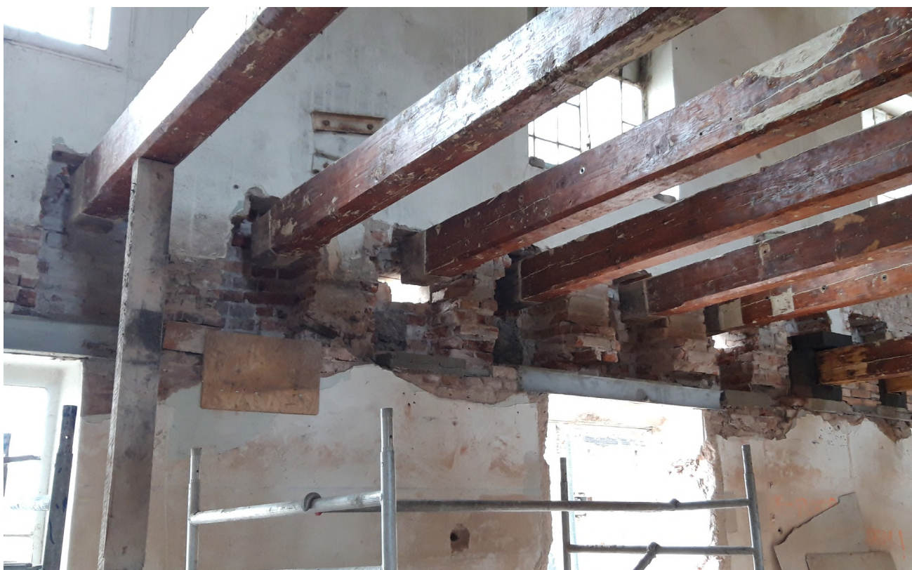
Obrázek 63: Provádění kapes zhlaví s tepelnou izolací z pěnového skla; foto: Jan Klečka, Metrostav a.s.
