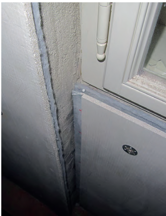
Obrázek 15: Zateplení historicky cenné fasády z vnitřní strany pomocí nanovláknité izolace aerogel - nevyhovující stropní konstrukce je nahrazena novou (ocelové nosníky), oddělenou od fasády tak, aby bylo možné tepelný izolant vést bez přerušení v celé ploše stěny; foto: Tomáš Vanický
