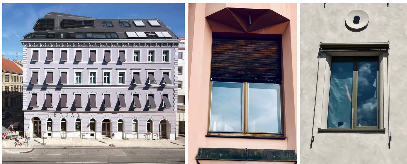
Obrázek 35: Příklad řešení vnějších stínících prvků na historických budovách; zdroj: Hiberatlas + foto: Michal Čejka
