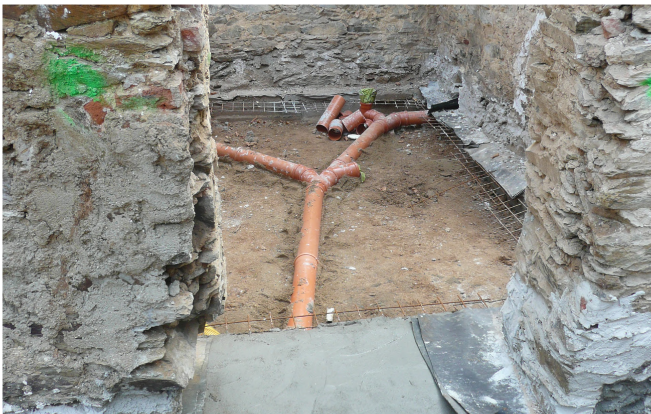
Obrázek 59: Řešení vztlínající vlhkosti zdiva – obvodové i vnitřní zdivo podříznuto s vložením hydroizolace; foto: Josef Smola, Centrum pasivního domu z.s.
