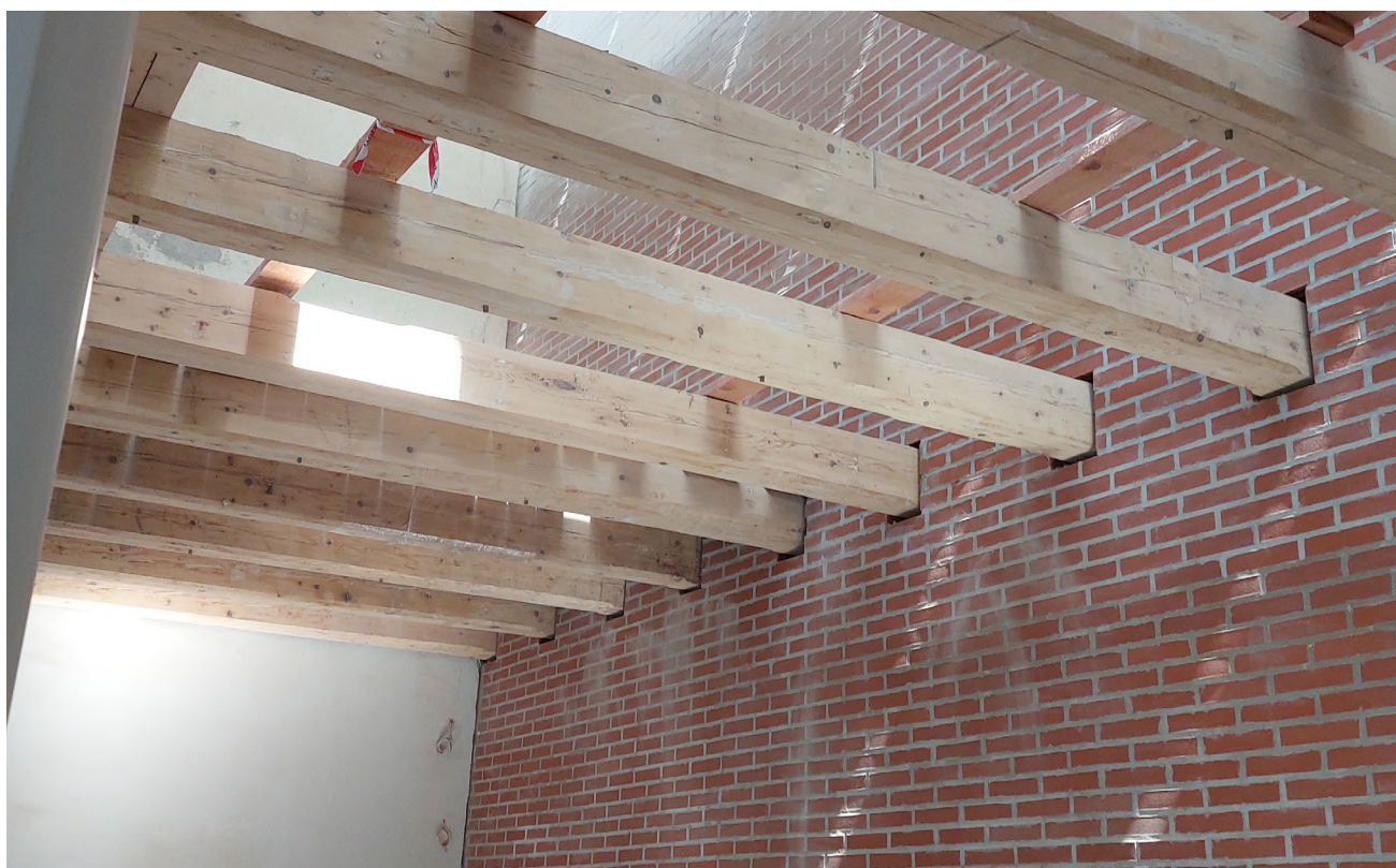
Obrázek 65: Osazení trámů s vnitřní přízdívkou a vnitřním zateplením; foto: Jan Klečka, Metrostav a.s.
