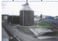
Foto 1: Zemědělská bioplynová stanice Trhový Štěpánov
