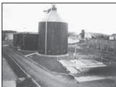
Foto 1: Zemědělská bioplynová stanice Trhový Štěpánov
