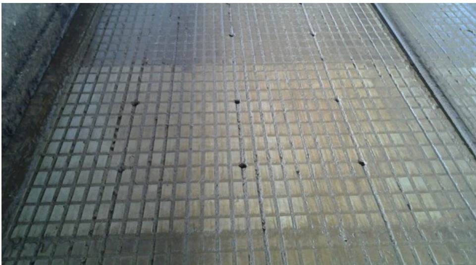
Obr. 4: Drážkovaná podlaha s otvory pro odvod moči
