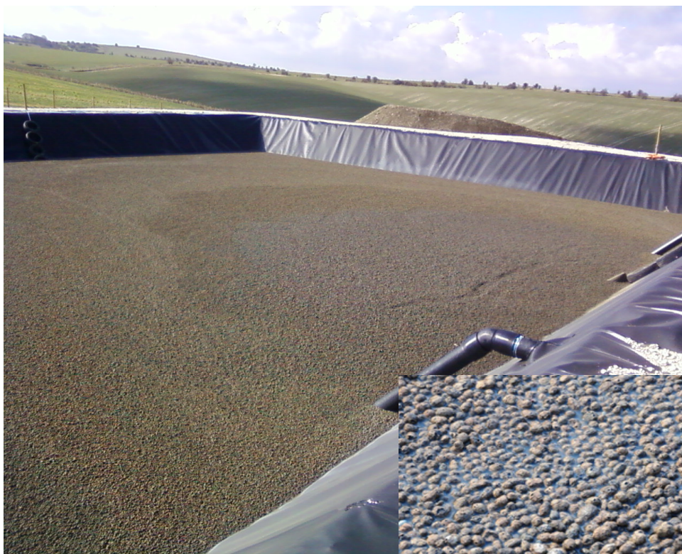
Obr. 13: Zakrytí zemní kejdomské jímky plovoucím povlakem LECA kuličkami
