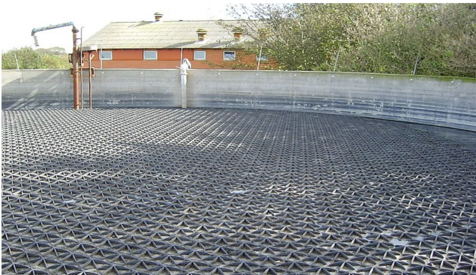
Obr. 14: Zakrytí jímky systémem Hexa Cover
