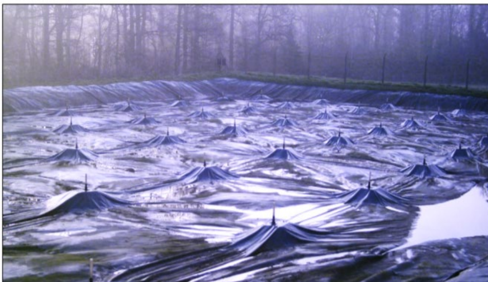
Obr. 11: Zakrytí nadzemní jímky plovoucí fólií
