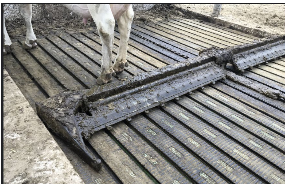
Obr. 4: Drážkovaná podlaha s otvory pro odvod moči
