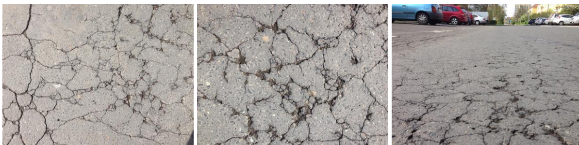
Obr. 6.17.: Silně poškozený povrch
