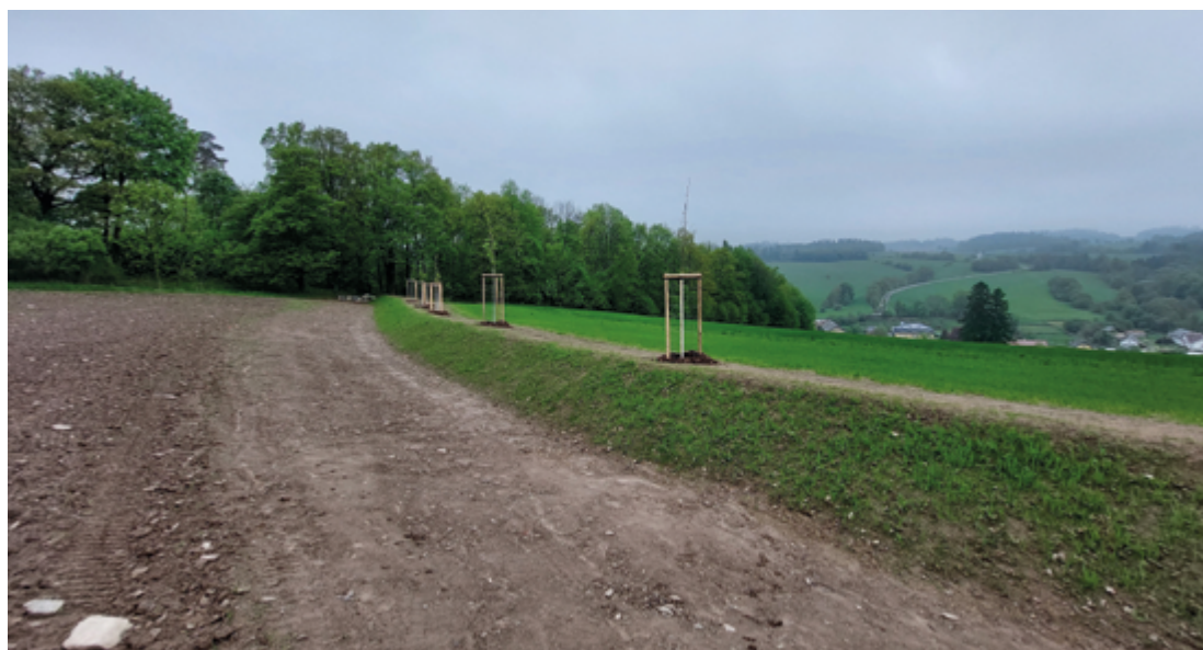
Obr. 1-37. Protierozní hrázka se záchytnou a vsakovací funkcí
