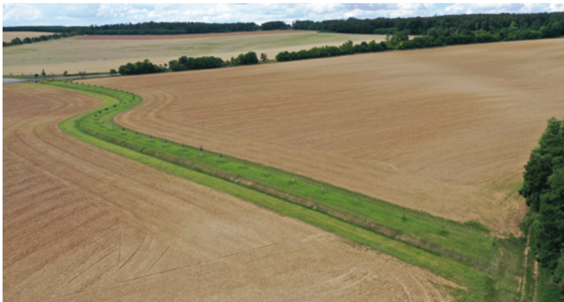
Obr. 1-30. Záchytný příkop s funkcí odváděcí bez zemní hrázky, se zasakovacím travním pásem a vegetačním doprovodem
