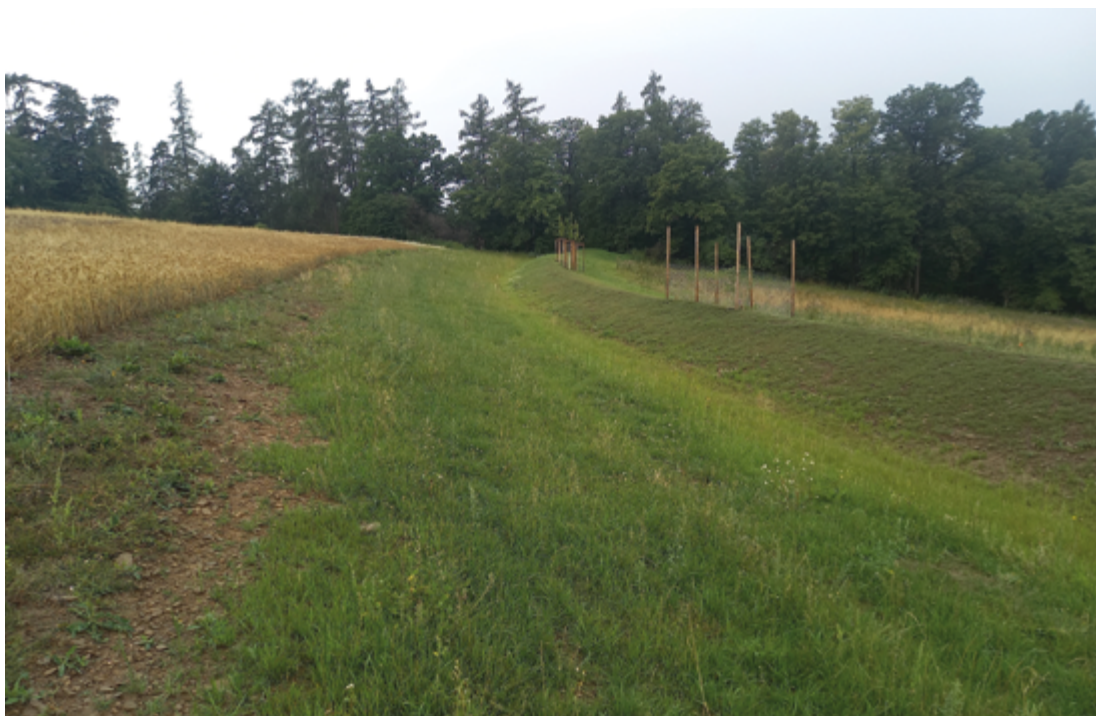
Obr. 1-27. Záchytný průleh s funkcí odváděcí se zemní hrázkou a ozeleněním
