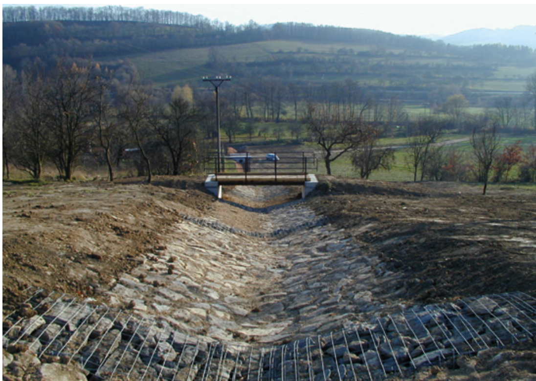
Obr. 1-49. Zpevnění svodného příkopu - kamenný pohoz, drátokamenné přehrážky
