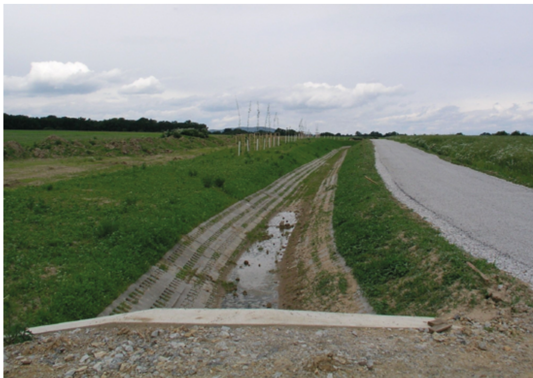
Obr. 1-47. Zpevnění svodného příkopu - polovegetační tvárnice
