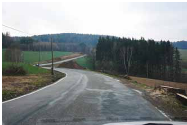
Silnice Ledec nad Sázavou – Havlíčkův Brod, pokácené stromořadí v délce několika km, zima 2006. Foto: Libor Štěrba
