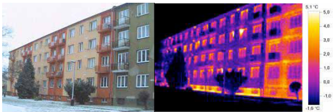
Obrázek: Termovizní snímek účinku zateplení obvodové fasády bytového domu; zdroj ENKI
