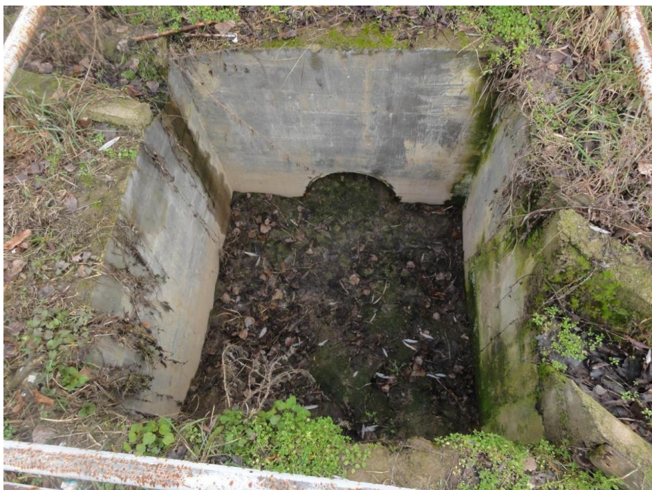
Obr. 2 - Zanesená vývarová jímka v uzávěrném profilu Bodu 1 - stav před 07/2016 (zdroj [30])
