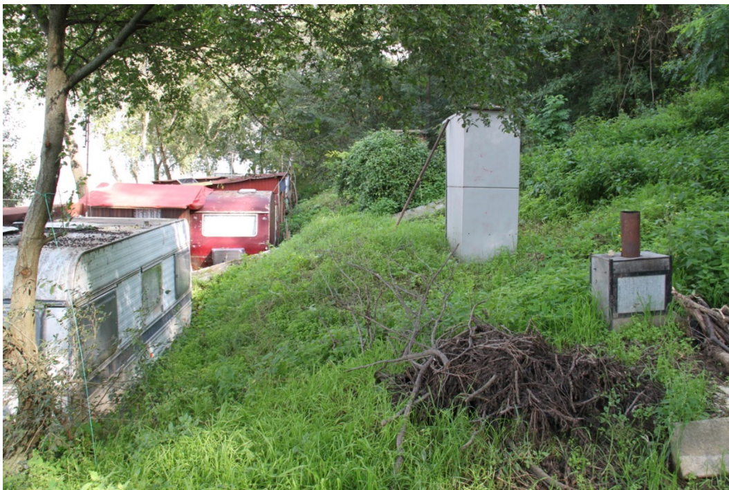
Foto 5: Pohled na čelo (akumulační část) aktivního frontálního sesuvu č. 1a (východní část) pod silnicí III/42117 mezi obcemi Dolní Věstonice – Pavlov s karavany zahloubenými ve svahu – v akumulaciční části sesuvného území. Foto: R. Novotný, 19.09.2014.
