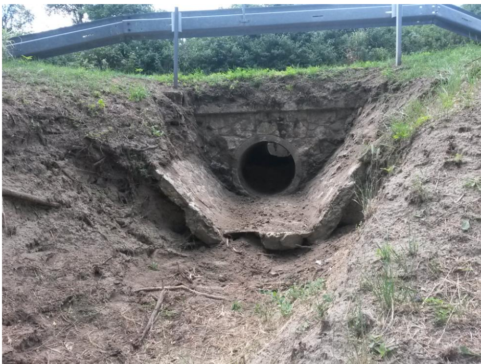
Obr. 7 - Uzávěrný profil Bodu 4 - stav po vyčištění 07/2016 (zdroj [33])
