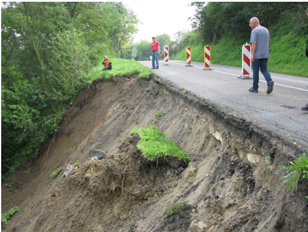
Foto 1: Pohled na odlučnou hranu aktivního proudového sesuvu č. 1a 1 v Dolních Věstonicích. Foto: R. Novotný, 15.09.2014.
