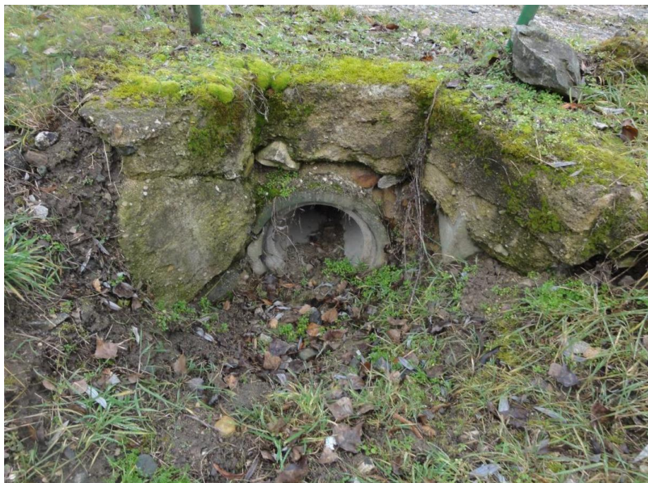
Obr. 1 - Nátok do propustku v uzávěrném profilu Bodu 1 - stav před 07/2016 (zdroj [30])
