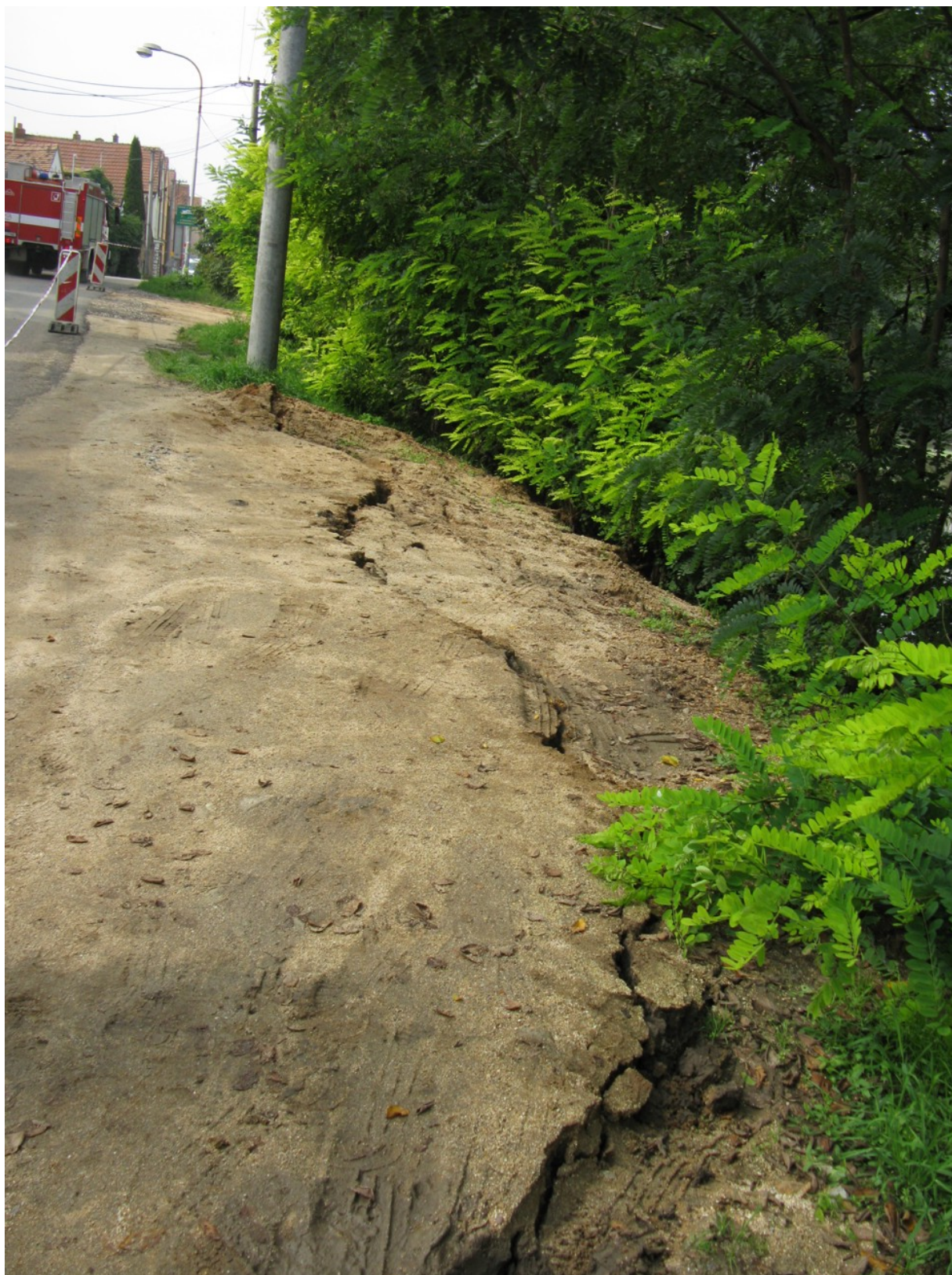
Foto 9: Pohled na odlučnou část s ohroženým sloupem VN v Dolních Věstonicích – sesuv č. 1f 1 . Foto: R. Novotný, 15.09.2014.
