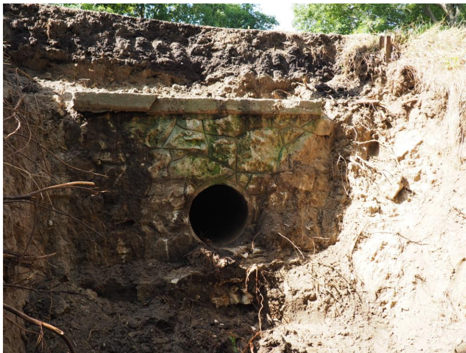
Obr. 5 - Uzávěrný profil Bodu 3 - potrubí DN 600 - stav po vyčištění 07/2016 (zdroj [33])
