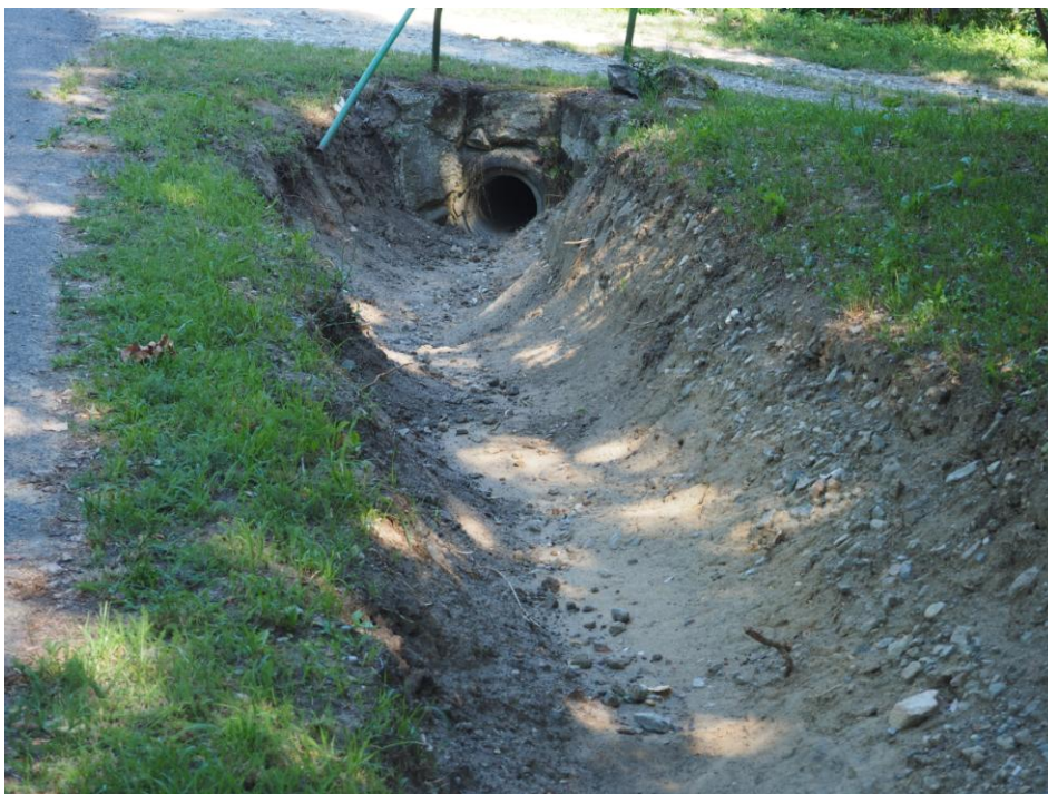
Obr. 3 - Nátok do propustku v uzávěrném profilu Bodu 1 - stav po vyčištění 07/2016 (zdroj [33])
