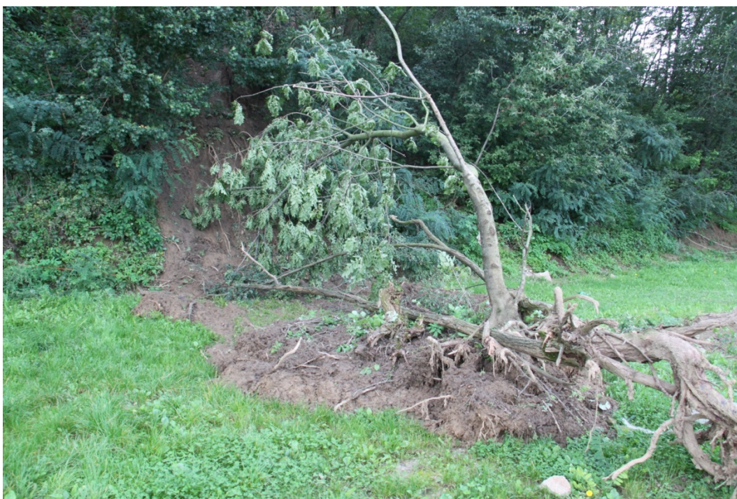
Foto 4: Akumulační část aktivního proudového sesuvu č. 1a (západní část) pod silnicí III/42117 mezi obcemi Dolní Věstonice – Pavlov. Foto: R. Novotný, 19.09.2014.
