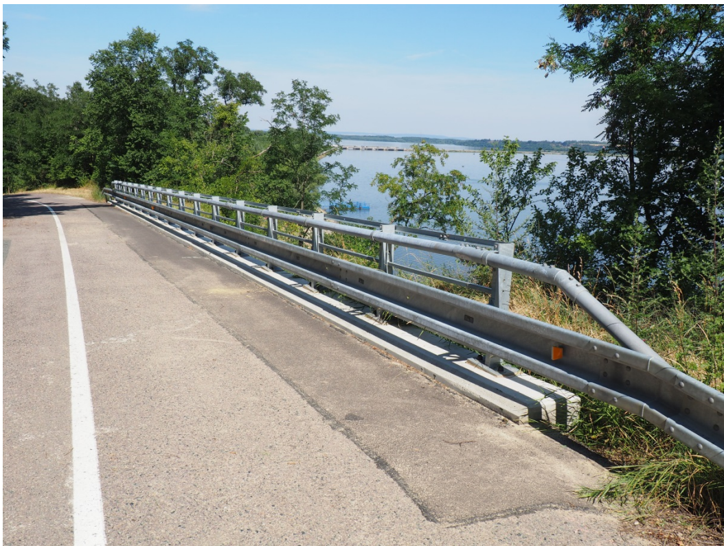
Foto 16: Funkční mikropilotová stěna dokončená v dubnu 2015 podle projektu Špičky (2014) v místě aktivního sesuvu 1a1. Foto: P. Kycl 07.07.2016.
