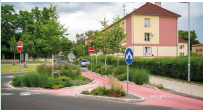
Do rekonstrukce ulic v Roudnici nad Labem prosadilo architektonické studio více zeleně, stromy a dešťové záhony s přerušovanými obrubníky, které podporují usakování dešťových vod. Foto: Nadace Partnerství, Vojta Herout
