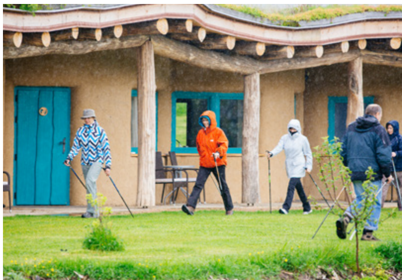
Školící středisko AKADEMIE Libchavy je vybudované kreatiivním způsobem v souladu s přírodou. Na první pohled zaujmou dřevěné sruby se zelenými střechami. Foto: archiv Akademie Libchavy
