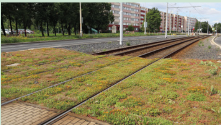
Zelený tramvajový pás s vegetační vrstvou na bázi minerální plsti. Jeden metr čtvereční takto ozeleněné plochy dokáže jednorázově zadržet až 61 litrů vody. Foto: ACRE, spol. s r. o.
