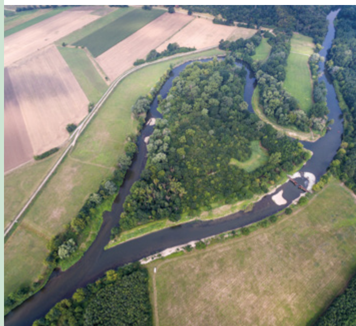
Nový prostor pro řeku Dyji. Napojením tří odstavených říčních ramen se výrazně zvýšila schopnost řeky zadržet vodu v lokalitě lužních lesů. Foto: Povodí Moravy, s. p., Vladimír Husák
