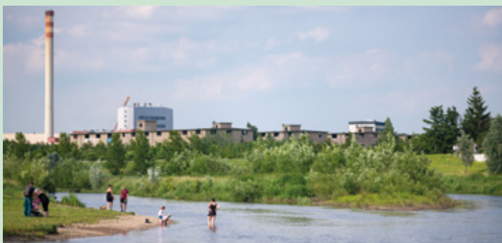
Protipovodňové opatření na řece Moravě na jihu Olomouce není jen technickým dílem, ale má i ekologický a společenský přesah. Foto: Nadace Partnerství, Vojta Herout
