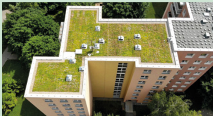
Vegetační střecha na panelovém domě v Brně-Bohunicích. Takovéto střechy mají význam jak pro obyvatele budovy, tak i pro její okolí – v létě ochlazují a v zimě omezují úniky tepla, při deštích zadržují vodu, čímž omezují nápor na kanalizaci a ulivy na vodní toky. Foto: GreenTop, s. r. o.
