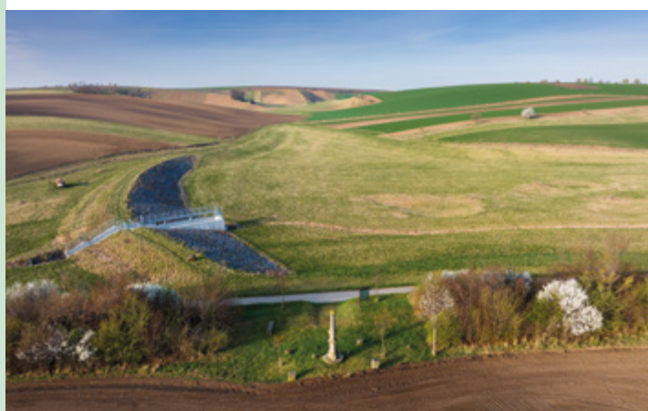
Suchý poldr u Šardic je součástí souboru opatření uskutečněných na ploše větší než 1600 ha, která pomáhají dlouhodobě řešit protipovodňovou ochranu obce, mírní dopady sucha a posilují druhovou rozmanitost. Foto: archiv obce Šardice, Radek Severa
