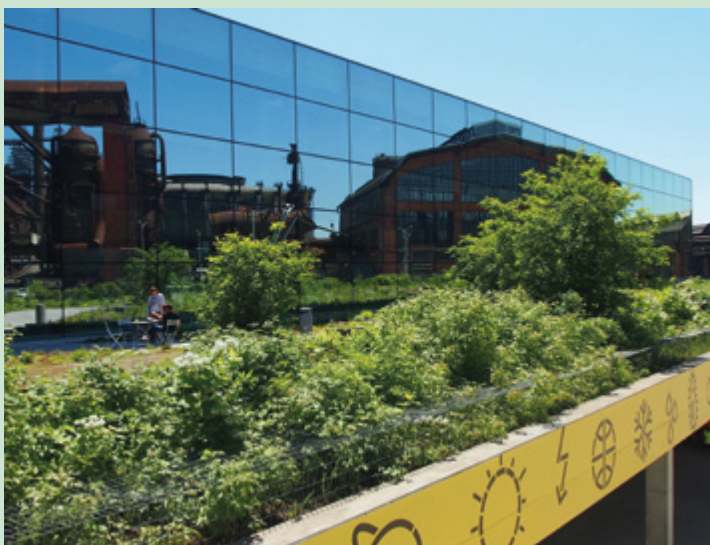
Zelená střecha Velkého světa techniky v Ostravě ukazuje paletu možností, jak lze přistupovat ke střešní zahradě, neboť prezentuje několik zahradnických i botanických osazovacích konceptů. Foto: Ateliér Zdeňka Sendlera, Brno
