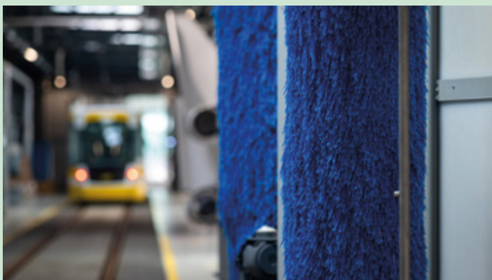
Rekonstrukce tramvajové vozovny Slovany v Plzni. Mycí linka využívá šedé a dešťové vody k mytí tramvajových vozů. Foto: Nadace Partnerství, Vojta Herout
