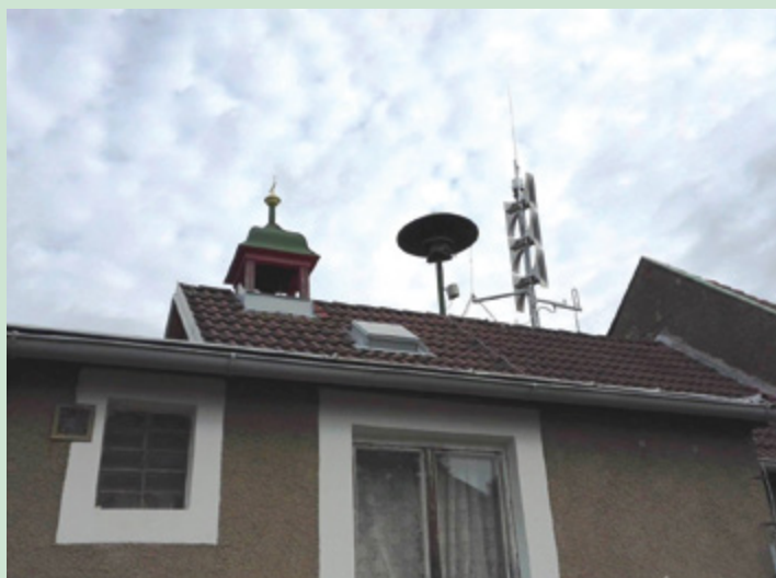
Adaptace z hlediska bezpečného prostředí – systém včasného varování a informování obyvatel. Vývoj varovných systémů – zvon, rotační siréna a elektronická siréna. Foto: SFŽP ČR
