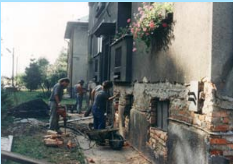
Katastrofální vliv antropogenních poklesů zemského povrchu na stavby. Rychlý pokles je způsoben poddolováním. Stavba je sanována technologií hydraulické nivelace. Foto F.Reichmann.
