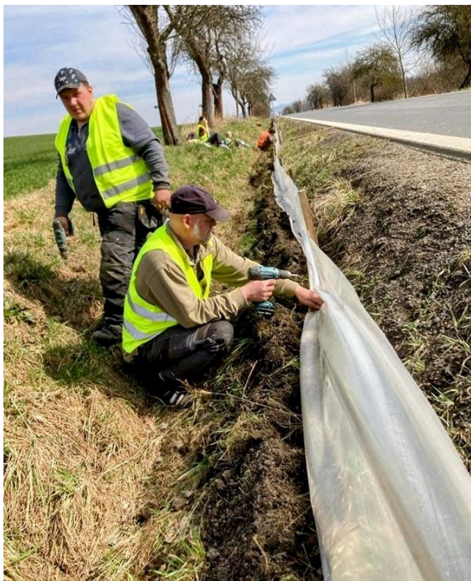
Budování zábran pro ochranu obojživelníků
