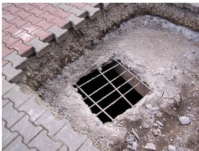
Obr. 5.25: Vyhledání staré jímky pod parkovištěm. 2D a 3D zobrazení tíhového měření a fotografie odhaleného vstupu do jímky.
