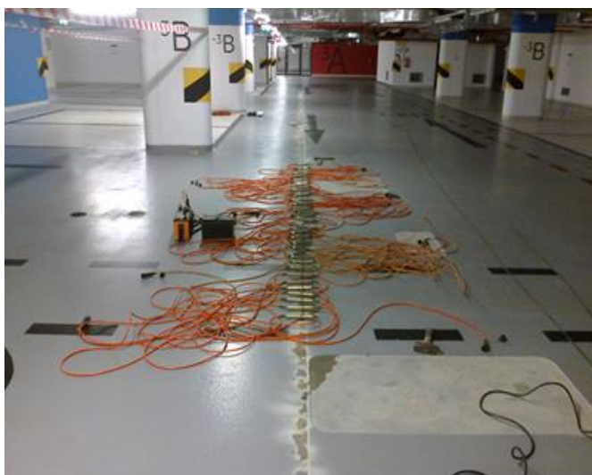
Obr. 5.8b: Příprava měření metodou ERT na podlaze podzemní garáže
